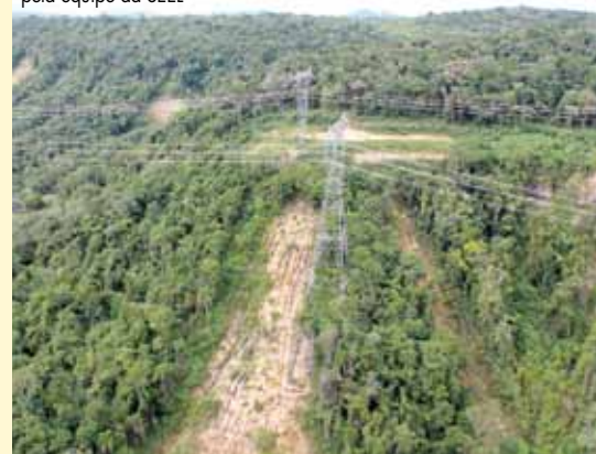
Imagem da Torre 374, antes do início das obras realizadas pela equipe da SEEL
