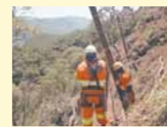
Funcionários da SEEL fazem a instalação da barreira dinâmica Geobrugg
