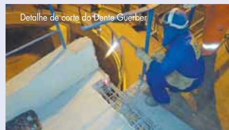
Corte do concreto para separar rampa caracol da parte central da passarela.
