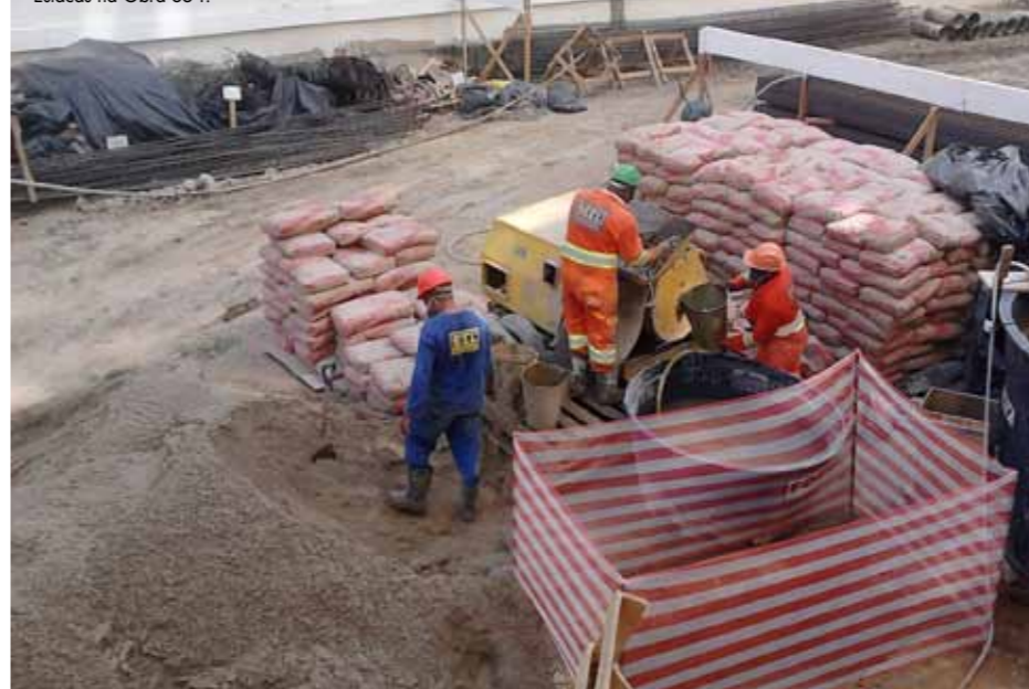
Central de Injeção (Bomba P13), para as Injeções das Estacas na Obra 654.
