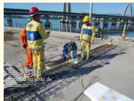
Colaborador da SEEL faz a recuperação estrutural do viaduto
