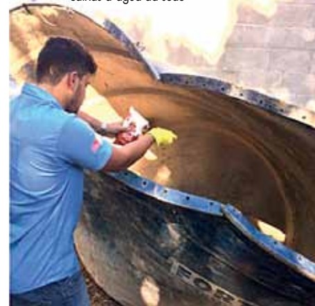
Adriano, estagiário da área da manutenção, coloca sal grosso em um das caixas d'água da sede
