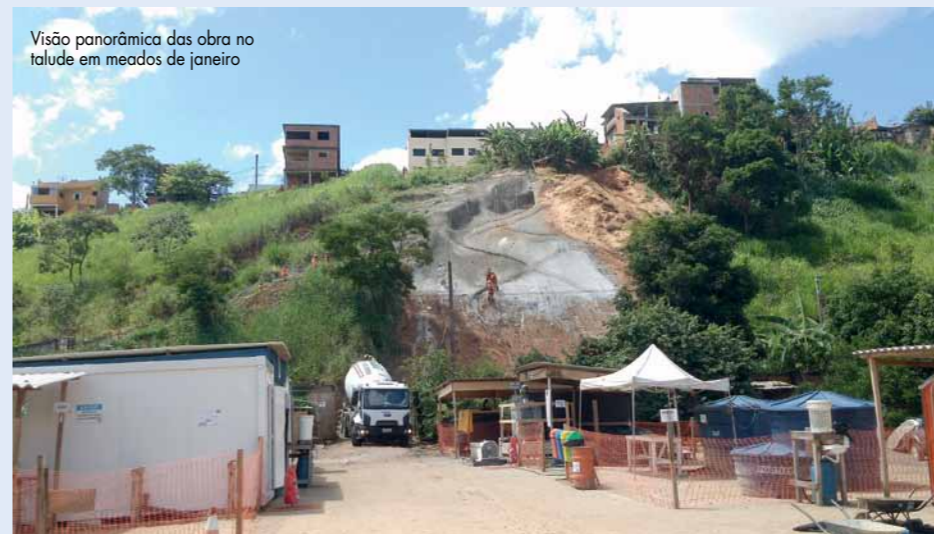
Com dois dias de implantação o concreto já atinge alta resistência, que vai aumentando ao longo do tempo.
