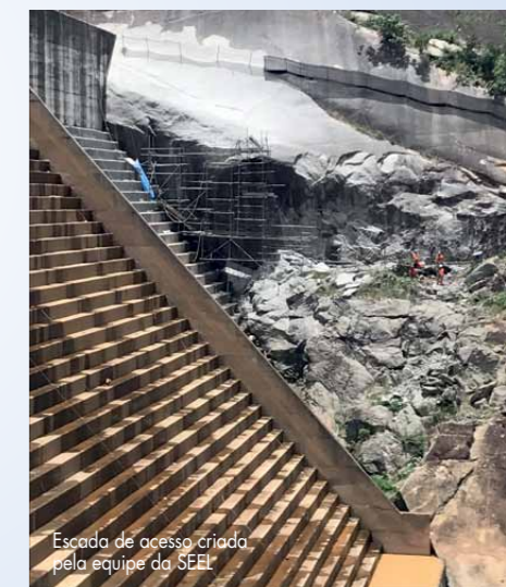
Panorâmica do trabalho no talude
