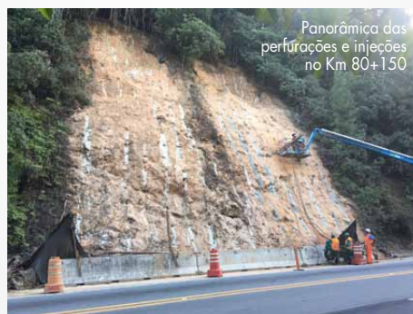
Plataforma auxiliar alpina para perfurações
