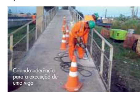
Hidrojateamento da estrutura
