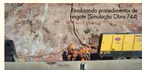
Chegada ao local de resgate (Simulação Obra 744)
