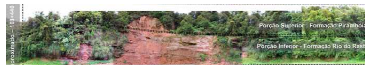
Figura 6: Representação contínua do trecho em estudo com as formações que compõem o talude (porção superior composta pela Formação Pirambóia e porção inferior composta pela Formação Rio do Rastro).
