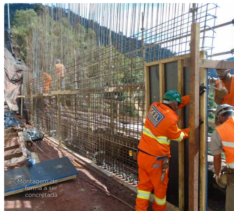
Detalhe da tela e chumbadores que afixam no alto no talude
