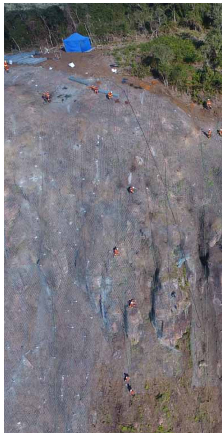
Para acessar os 99m do topo cada um dos alpinistas leva apenas 10 minutos, utilizando as gigantescas escadas construídas, em seguida descem por cordas, trabalhando nas telas
