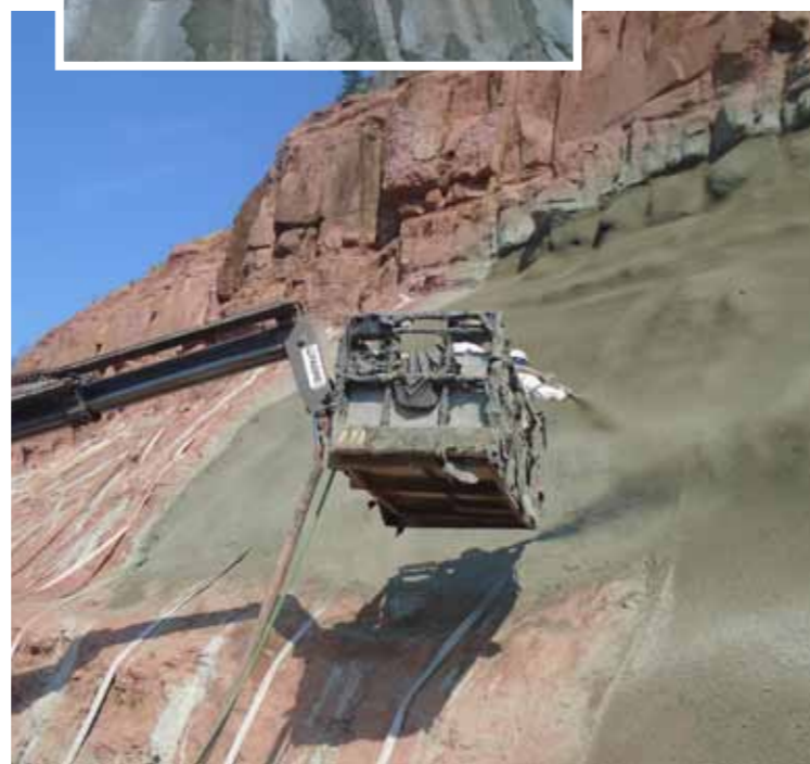
Projeção de concreto (imagem maior) e concreto finalizado no trecho 4 (imagem em detalhe)
