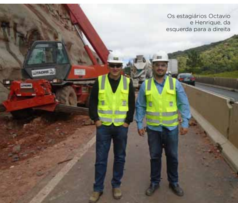
Construção da canaleta da Cortina 2
