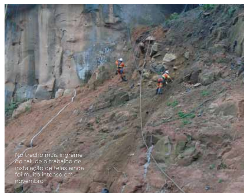
Alpinistas realizam meticuloso trabalho de limpeza na área onde ocorreu a detonação
