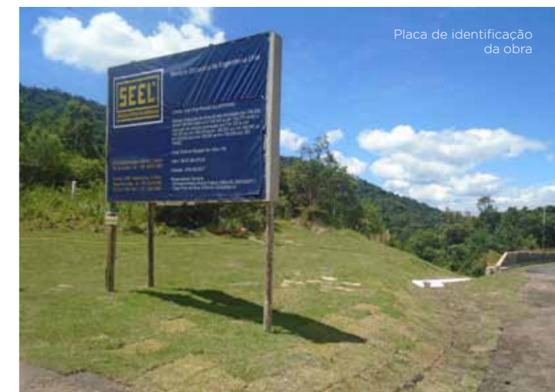
Vista frontal, trecho 6 e 7. Concreto projetado e acabamentos
