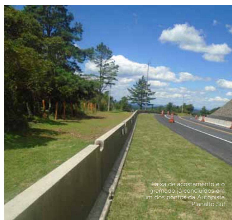
Belíssima imagem em close da Cortina2 finalizada no ponto 23 da obra com o entorno gramado
