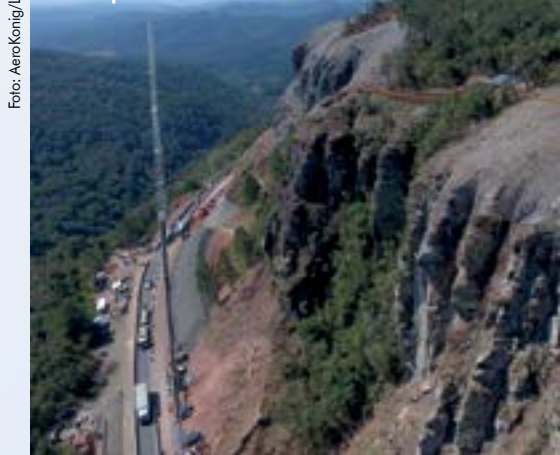
Obra da Serra do Espigão foi “a grande virada de chave” para a SEEL
