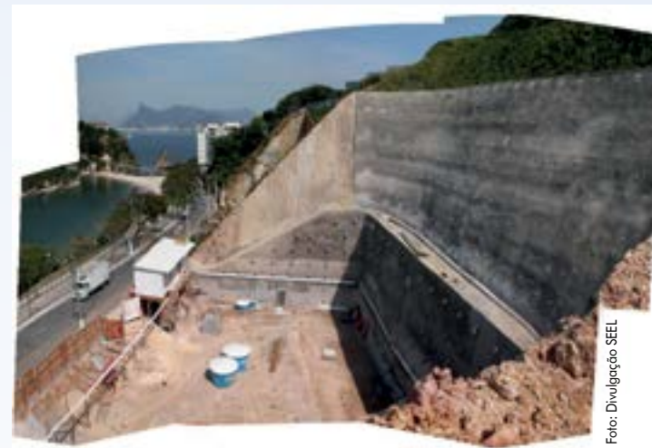
Solo grampeado a 40 metros de altura em Niterói criou referência acadêmica
