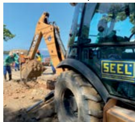
Escavação para Linha de Recalque - Praia José Bonifácio - Ilha de Paquetá
