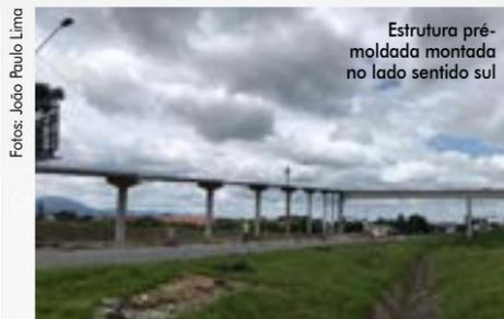
Estrutura pré-moldada montada no lado sentido sul
