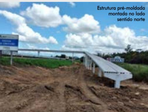
Estrutura pré-moldada montada no lado sentido norte
