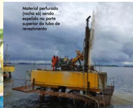
Material perfurado (rocha sã) sendo expelido na parte superior do tubo de revestimento
