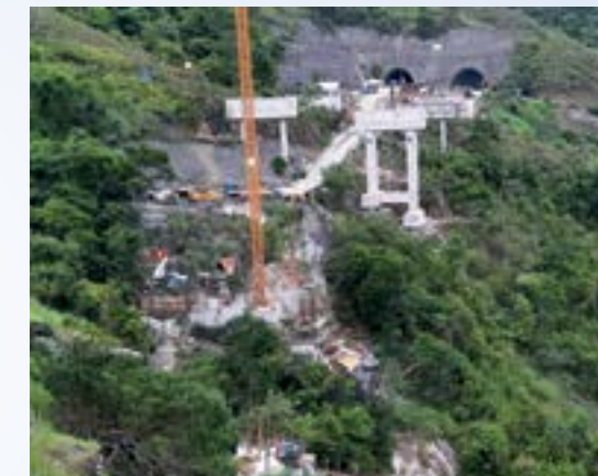
Panorâmica da obra de contenção ajuda a entender que sem esta a obra maior não poderia prosseguir
