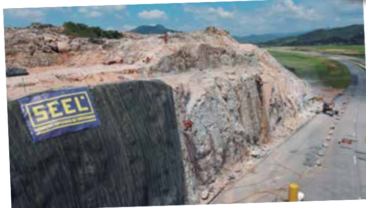
Obra 926. Estabilizar taludes garante proteção ao intenso fluxo de veículos
