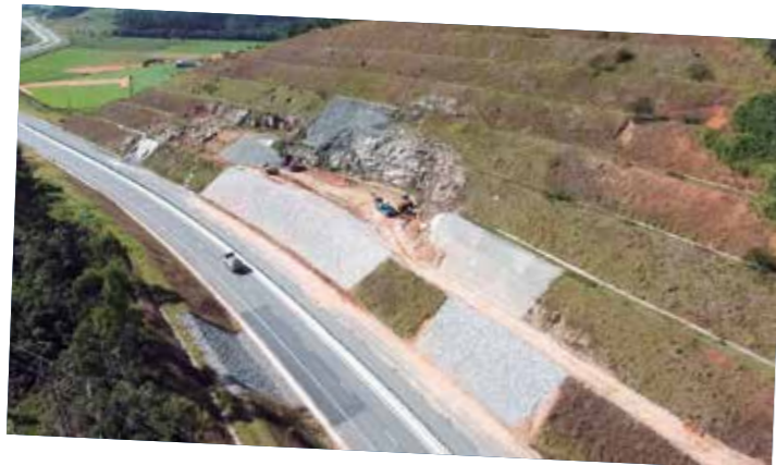
Obra 929. Enrocamento garante segurança de tráfego
