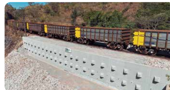
A contenção em concreto projetado e a cortina atirantada, com enrocamento e muro de gabião às margens da ferrovia.
