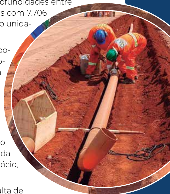
Trabalho de escavação e instalação da tubulação de esgoto/interligações
