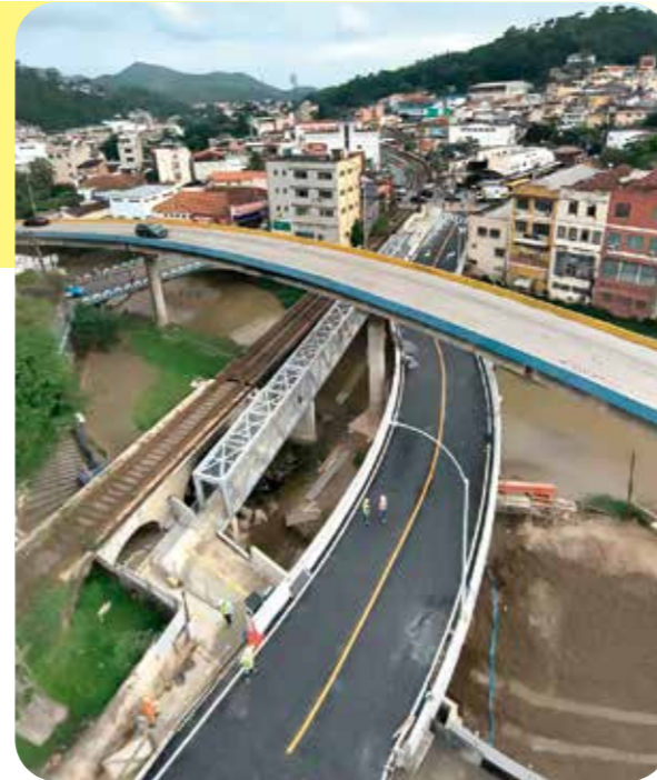
Imagem aérea da ponte e passarela recém-inauguradas
