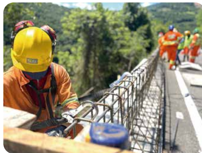
Imagem da obra às margens da Rodovia BR-470
