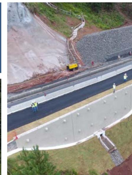
A **obra do segmento Rodovia** envolveu a elaboração de projetos e a execução de obras emergenciais de estabilização de taludes na BR-470, localizada no município de Bento Gonçalves (RS). Com alto grau de complexidade técnica, a intervenção integrou o esforço de reconstrução da infraestrutura viária afetada pela catástrofe climática ocorrida em maio de 2024.
