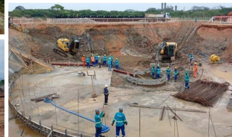
A **obra do segmento de Mineração** contemplou a execução de serviços de terraplenagem e drenagem voltados à preparação da área destinada à pilha de disposição de estéril e rejeito, materiais sem valor econômico gerados no processo minerador. A estrutura desempenhou papel estratégico para a segurança operacional e ambiental, especialmente em um contexto que exige reforço nas práticas preventivas após os episódios de rompimento de barragens em Minas Gerais.
